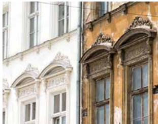
Fenster und Fassade
